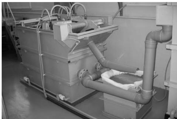
Рис. 2. Электрофлотатор на ОС гальванического производства ОАО «ЖМЗ», Жуковский
